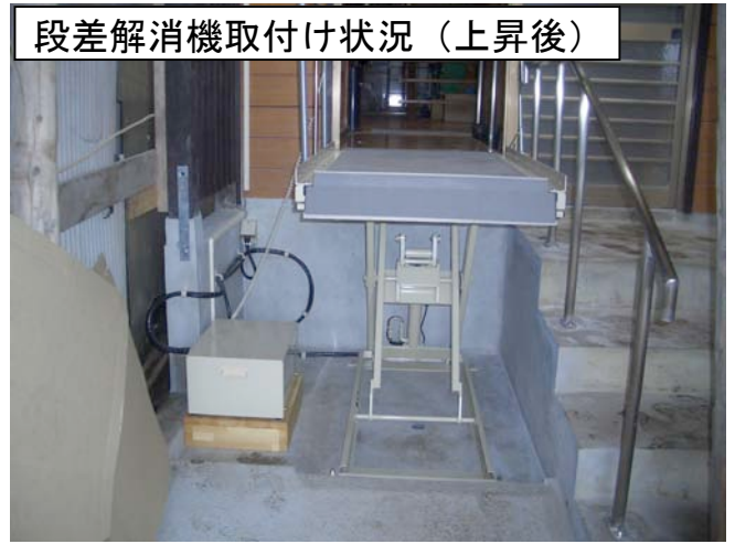
階段昇降機取付け後
