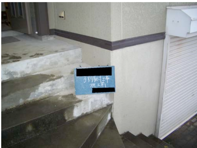
外階段手すり取付け前
