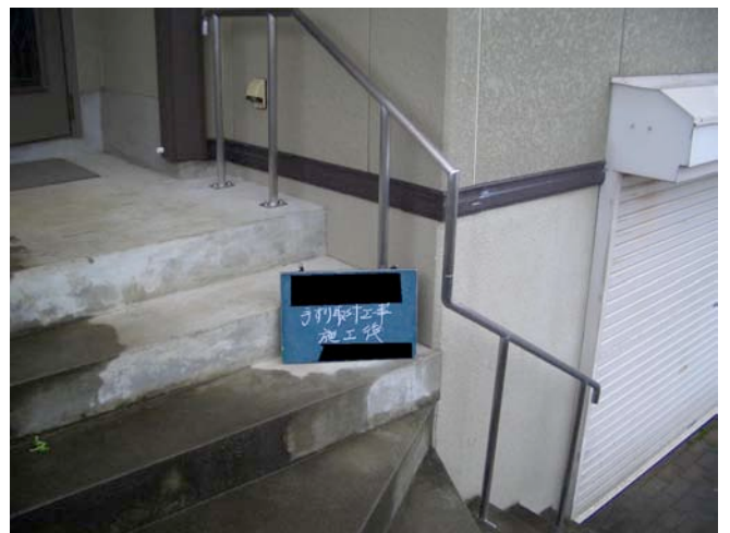
外階段手すり取付け後
