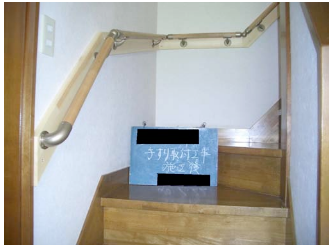
階段手すり取付け後
