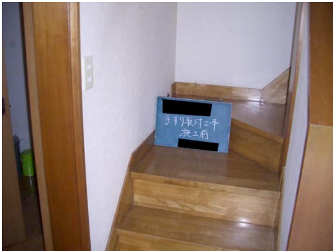
階段手すり取付け前
