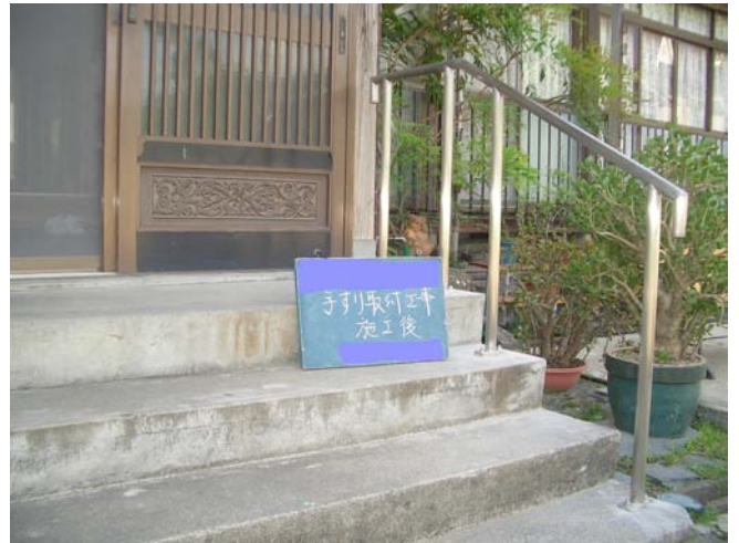
外階段手すり取付け
