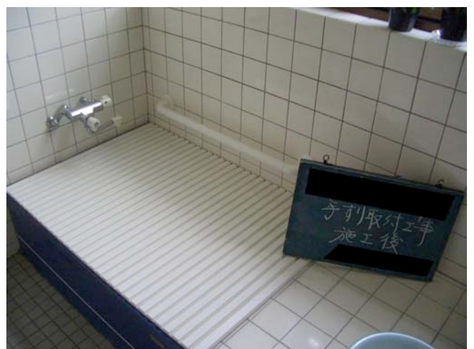
浴槽内手すり取付
