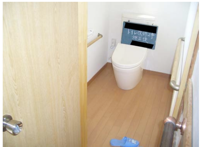
トイレ改装と手すり取付
