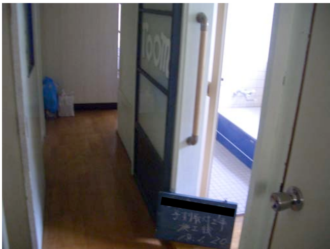
浴室入り口手すり取付け
