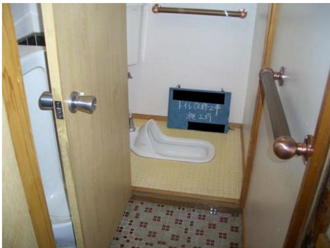
トイレ改装前手すり状況
